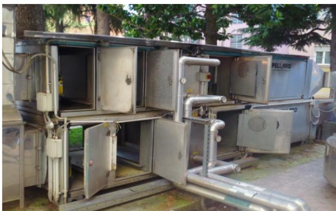
Si procederà pertanto allo smontaggio del motore elettrico, del ventilatore, del telaio poggia motore, del separatore di gocce, delle serrande ed altri componenti usurati.
