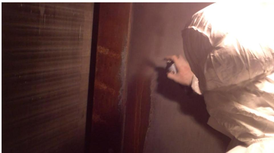
Per avere un risultato ottimale la vernice ha bisogno di 8 - 12 ore per un asciugatura completa e uniforme, in funzione anche delle condizioni climatiche esterne.
